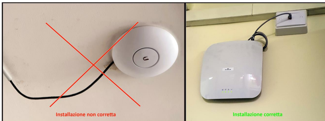
Figura 10 – Installazione corretta dell'Access Point
